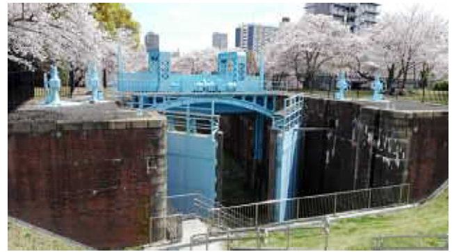
1896年（明治29年）に現在の淀川と旧淀川（大川）の間に生じた水位差をコントロールして安全に船を航行させた
